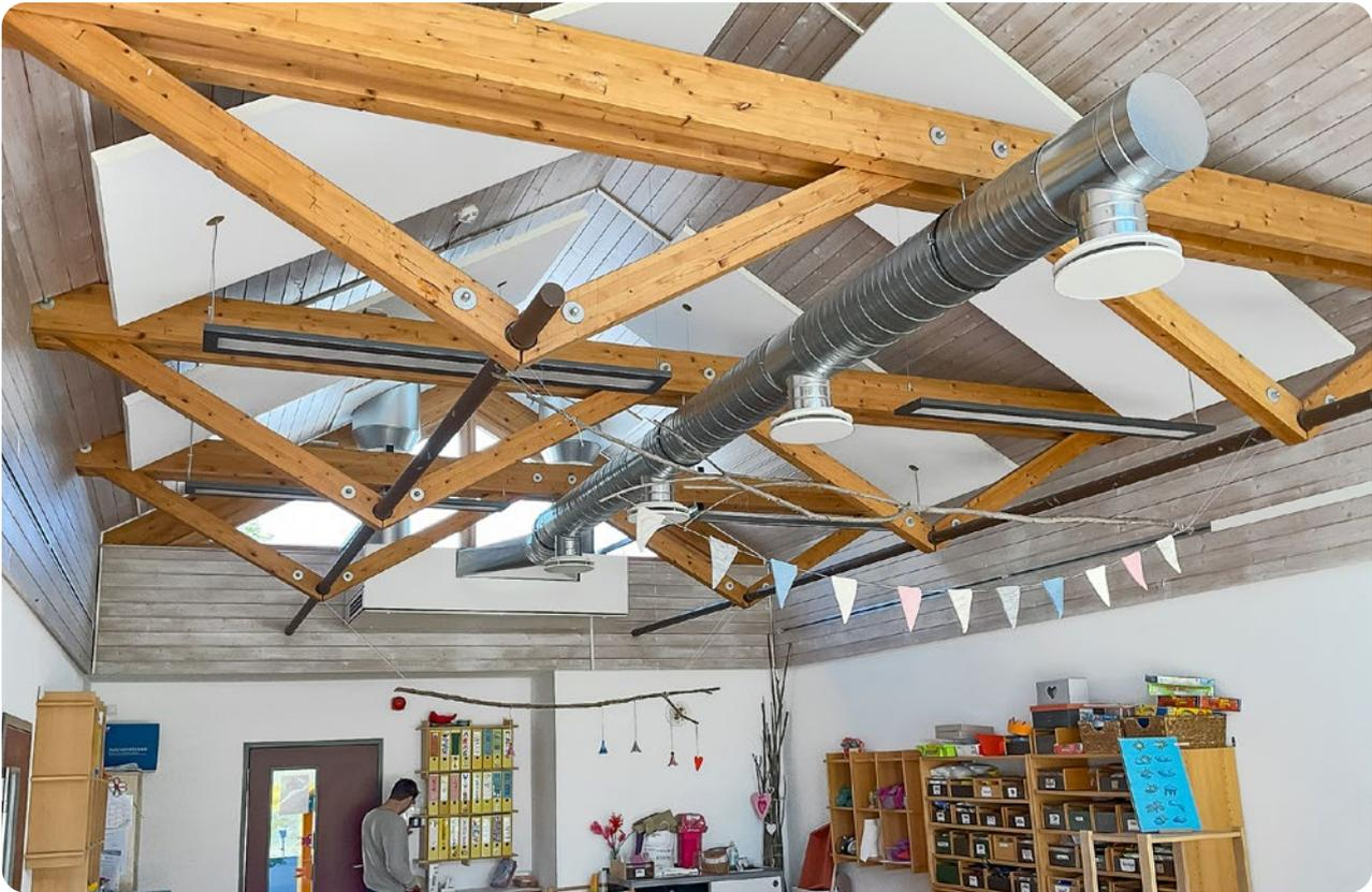
Die verwinkelte Einbausituation mit Schrägdach erforderte eine Spezialkonstruktion: Wie bei einer zentralen Anlage wurde das dezentrale Lüftungsgerät DUPLEX Vent an einen Zuluftkanal angeschlossen.
